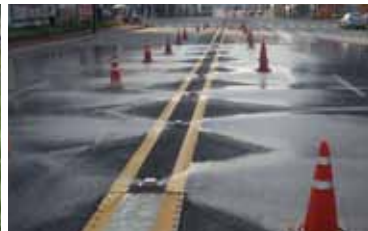
구리시 갈매 공공하수처리시설 하수처리수 재이용
